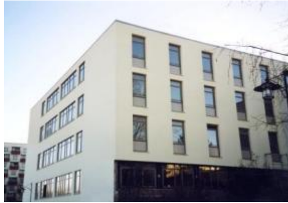
Bezirksklinikum Regensburg , Hinterlüftet, Putz
